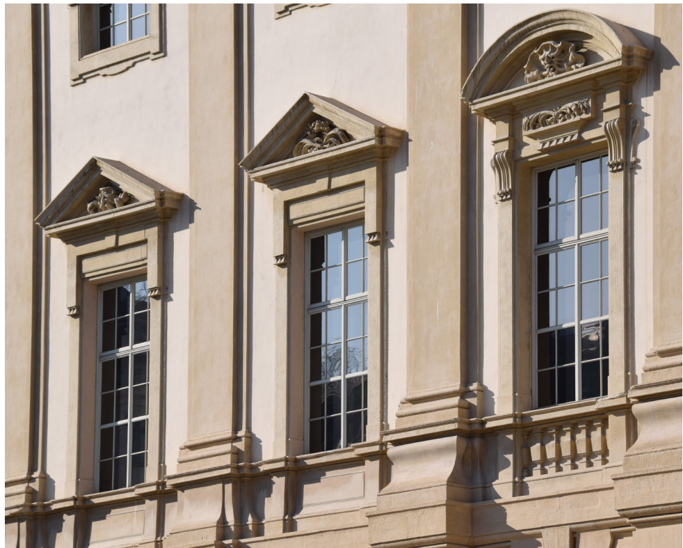
Abb. 03 Gartenpalais Liechtenstein 2026 Dokumentation und Erfassung Fachlich Begleitung Prozessgestaltung
